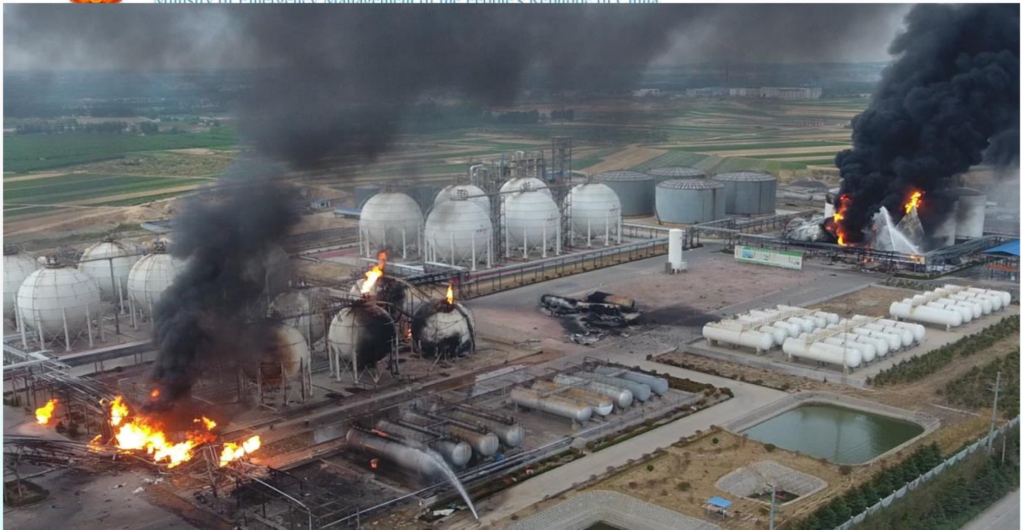
事故现场全景
