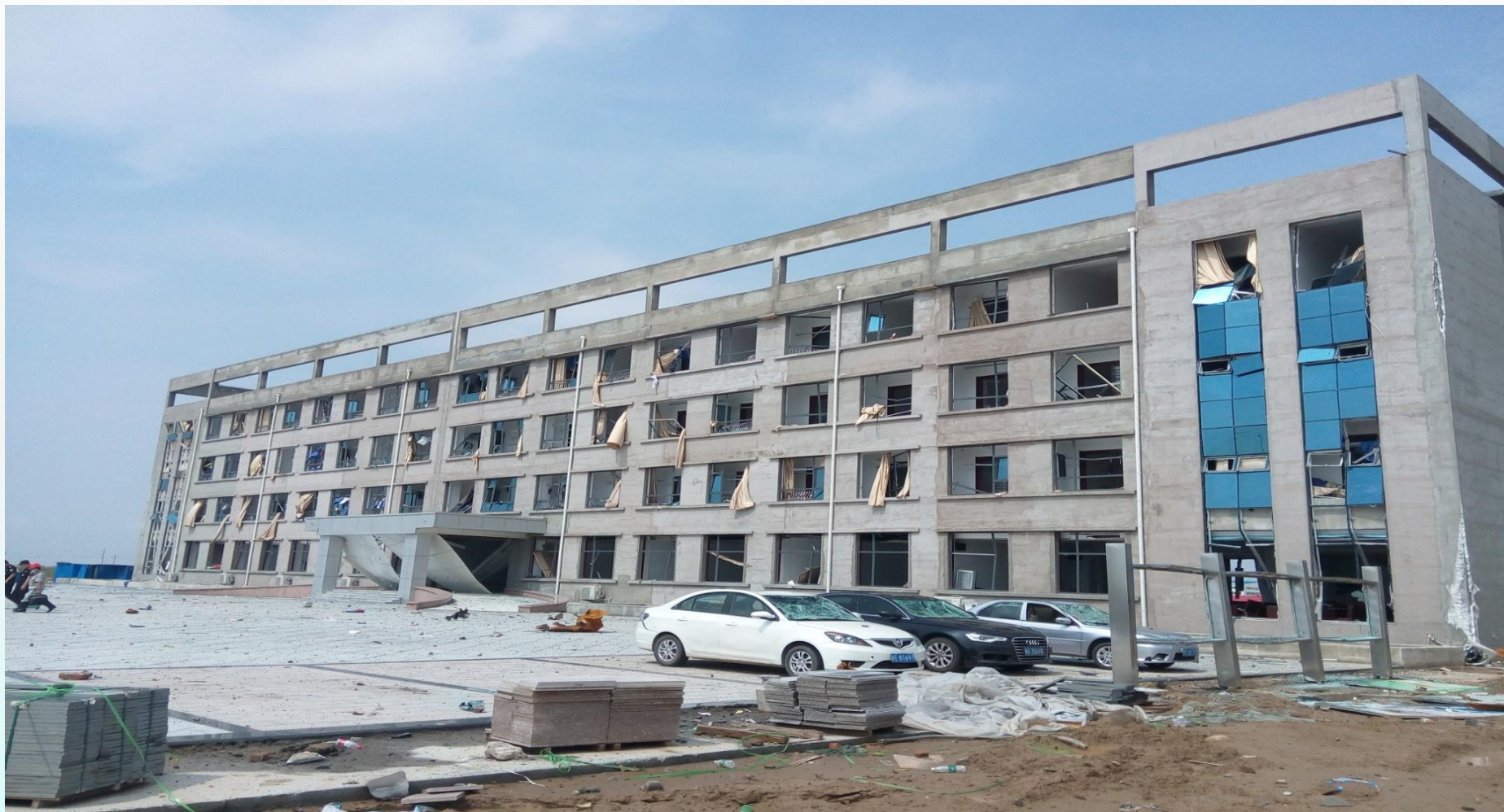
事故装置西侧约50米处的综合楼 (一楼办公，其余楼层为宿舍)
